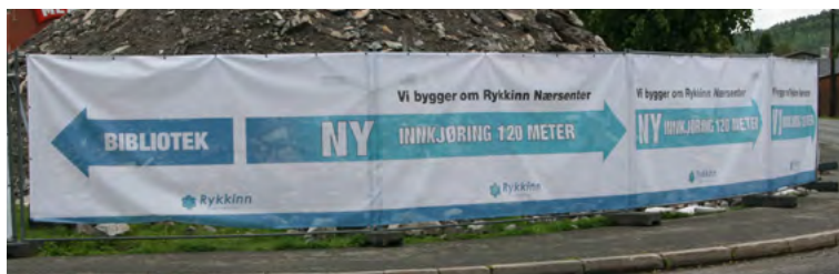
Hel duk på 14 m. Gir god informasjon til besøkende på senteret. Dekkduker skaper vindfang, og det er viktig med god nok sikring ved hjelp av støttestag og tilstrekkelig motvekt.
