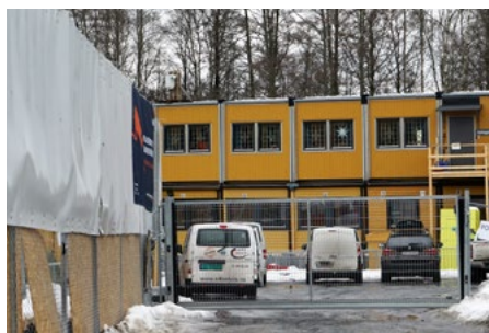
Skyvegrind med adgangskontroll.
