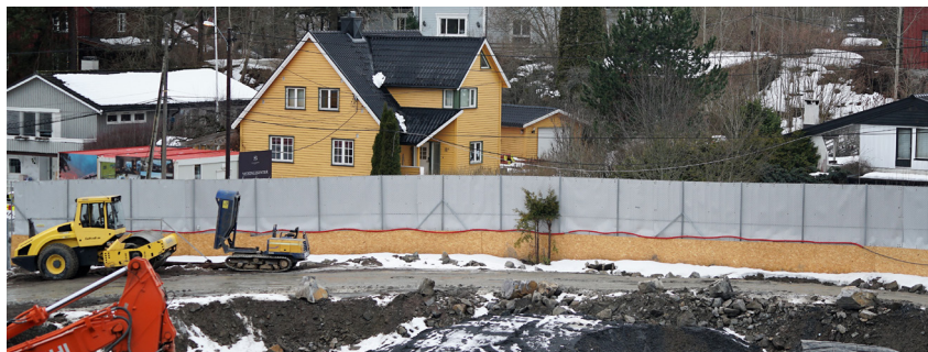
Duken benyttet på gjerde rundt byggeplass ved boligområde.
