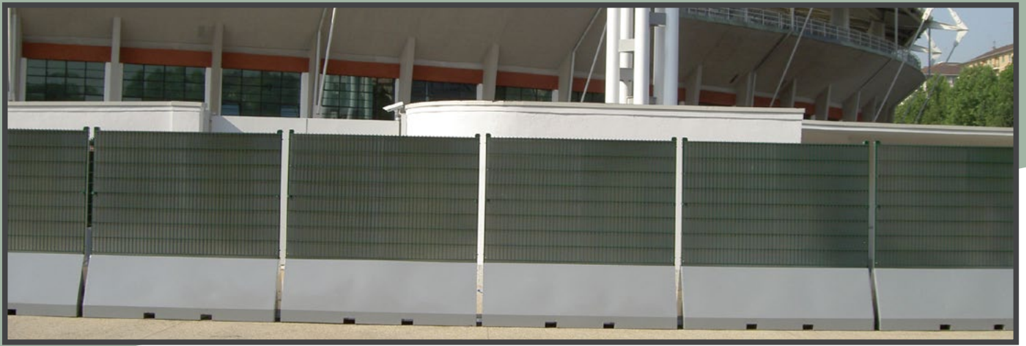
Elementgjerd med Nylofor 2DS og stållplate ved stadion i Salerno, Italia.
